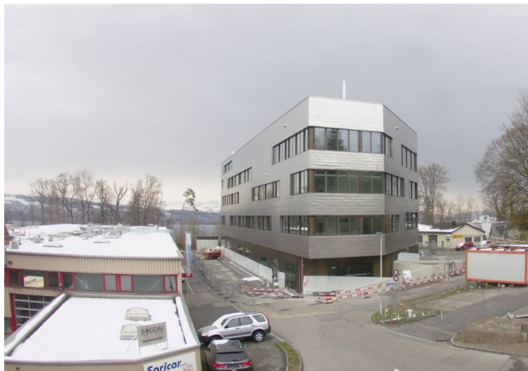
Abbildung 6: Gebäude während des Innenausbau (Bild: Webcam der Baustelle, Tuwag Immobilien)
