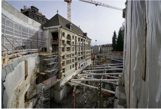
Abbildung 5: Bestehendes Gebäude der Bibliothek mit Baugrube (Bild: Charles Ellena)
