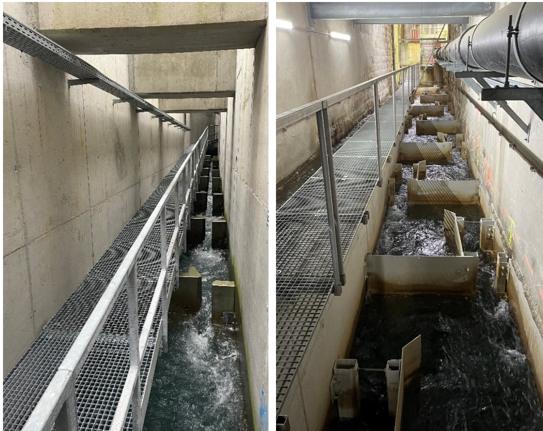
Abbildung 1: Beispiele von Fischtreppen aus Beton (links) und aus Metall (rechts), die es den Fischen ermöglichen sollen, ein Gewässer hochzuschwimmen und dabei das Wasserkraftwerk zu umgehen; Quelle: EFK.
