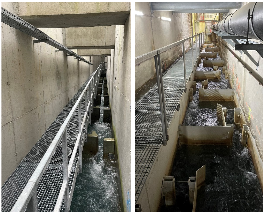
Illustration 1 : Exemples d'escaliers à poissons en béton (à gauche) et en métal (à droite) construits pour permettre aux poissons de remonter un cours d'eau en contournant l'installation hydroélectrique, source : CDF.
