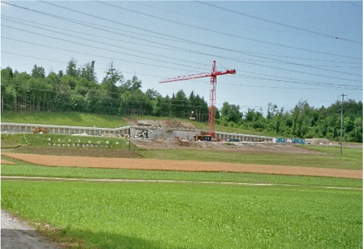
Baustelle Überführung Isenberg, Ausblick Wald. Quelle: Pfenninger/ Perrin, 2006.
