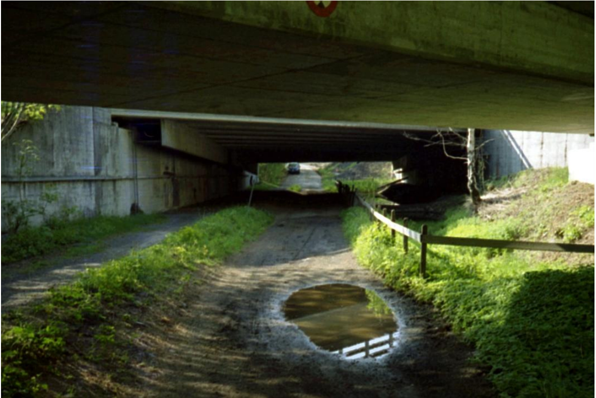
Unterführung unter Bahn- und Autobahnbrücke, Flurweg, rechts Retentionsbecken. Quelle: Pfenninger/ Perrin, 2006.
