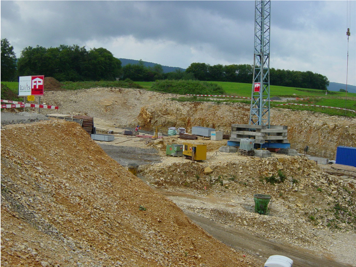
Les Essapeux en construction. Quelle: Crémieux, 2005.
