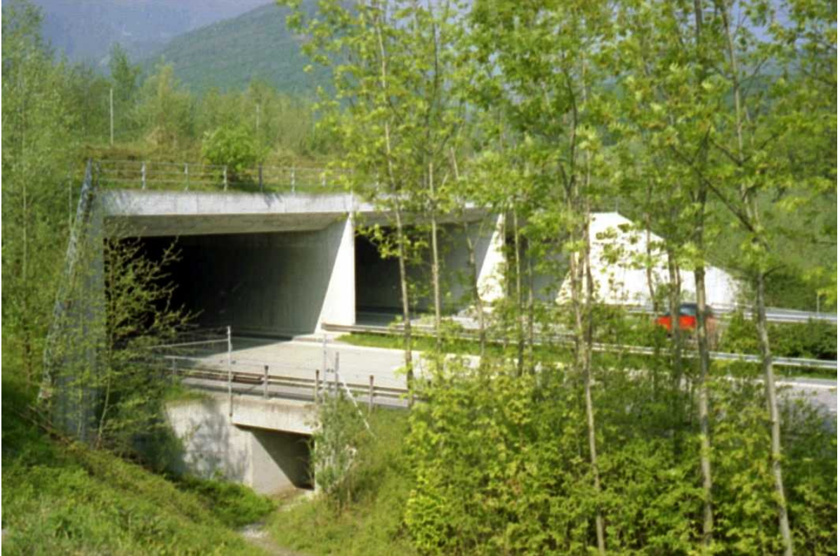
Wildtierpassage Hirschsprung, leicht überwachsen (gebaut 1999), rechts davon Kleintierunterführung (gebaut 1968). Quelle: Pfenninger/ Perrin, 2006.
