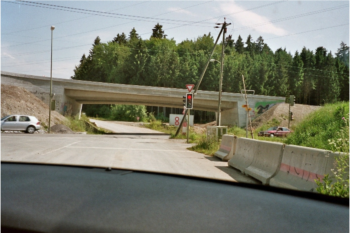
Chilchmatt, Richtung Süden (die Zufahrtstrasse wird abgebaut). Quelle: Pfenninger/ Perrin, 2006.
