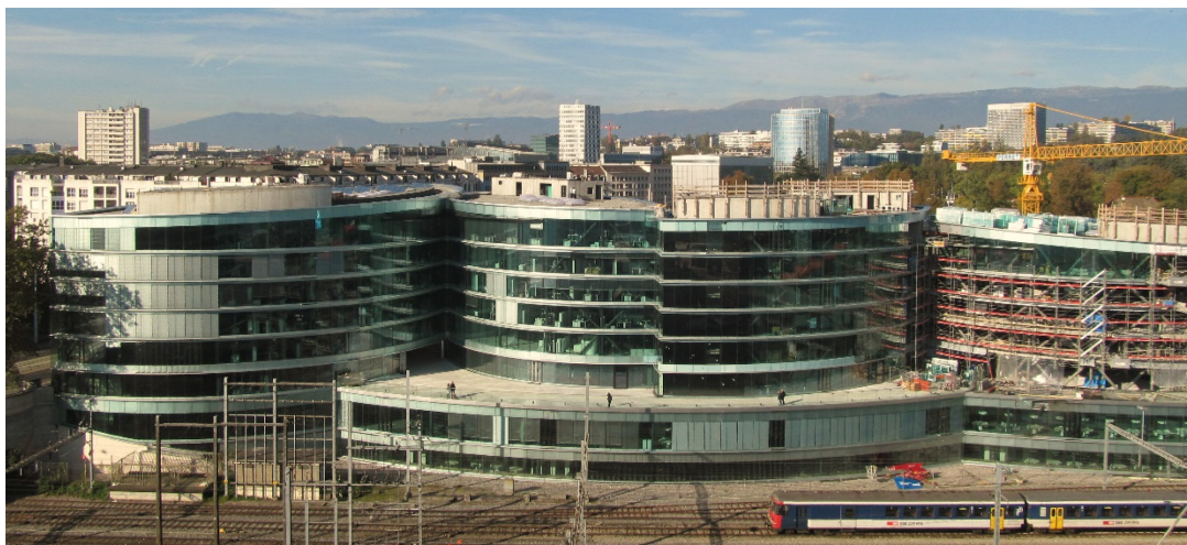
Illustration 1 : Le chantier de la Maison de la Paix en octobre 2013 à Genève (CC-0)
