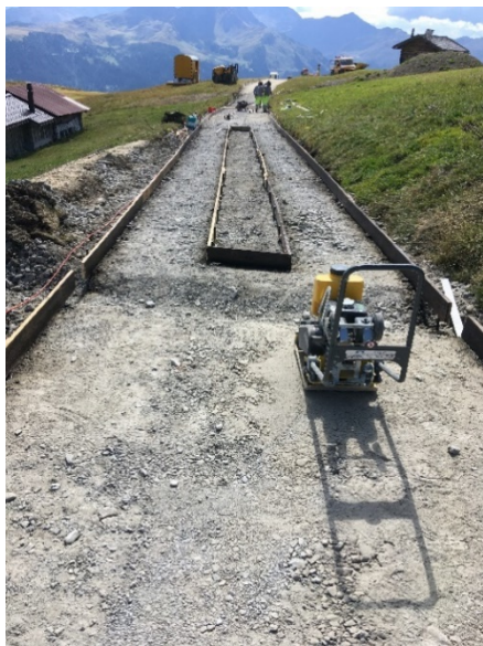
Abbildung 3: Betonspurweg mit wasserdurchlässigem Unterbau (Kofferung) im Bauzustand im Gebiet des Flachmoors Faninpass
